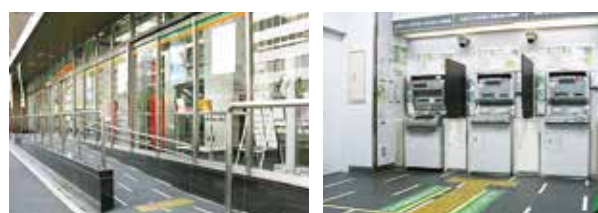
スロープや点字誘導ブロックなどの設置例(東京・芝店)
